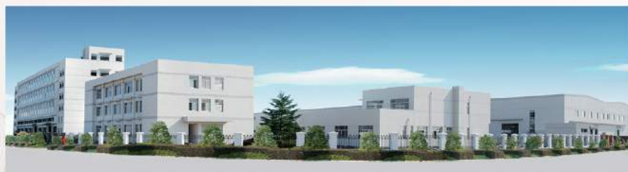
開山上海臨港工業園 佔地面積16033坪，建築面積12100坪
